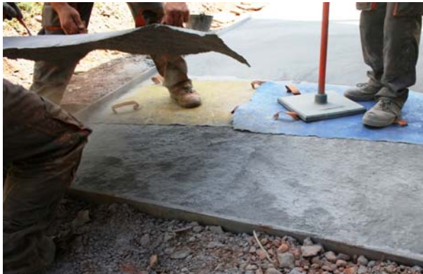
7. Utilizar pisón para mejorar la impresión (si lo precisara)
