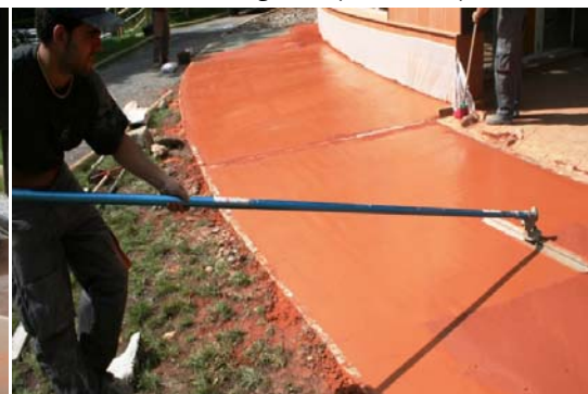
4. Incorporar capa de rodadura ankare zaline con llana de acero cerrando el poro.
