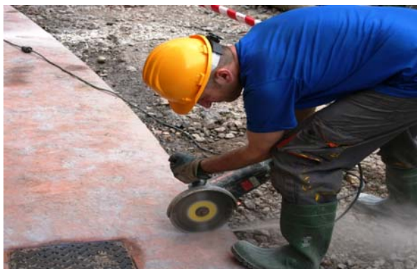
9. Realizar cortes de juntas a los 1/3 días
