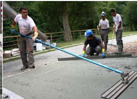
2. Alisar la superficie de hormigón fresco con talocha de magnesio para abrir poro
