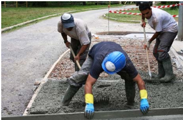
1. Extender el hormigón, maestrear y reglear la superficie
