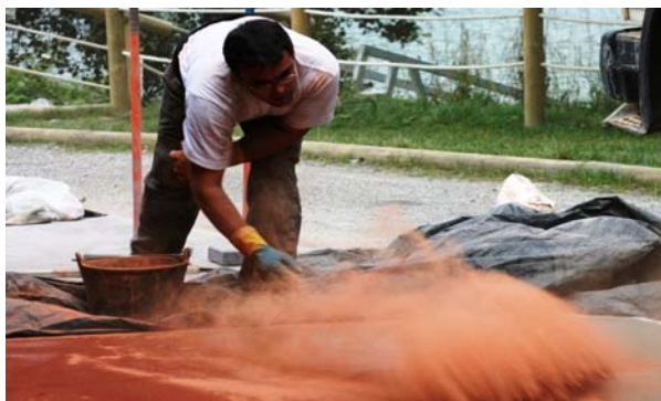
3. Aplicar ankare zaline (capa rodadura) 4-6 kgs/m 2 y alisar con Talocha Magnesio para fijar el endurecedor dejando el poro abierto.
