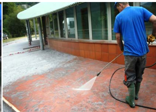
10. Realizar lavado con agua a presión a los siete días
