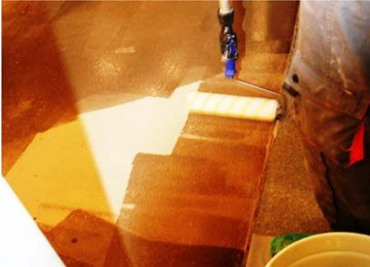
**ankare kui coat 112** es un recubrimiento de poliuretano monocomponente transparente con disolventes.
