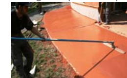
4. Incorporar capa de rodadura ankare zoline con llana de acero para cerrar poro en dos o tres veces
