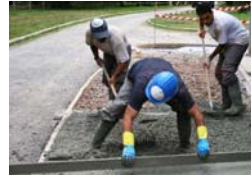
1. Extender el hormigón, maestrear y reglear la superficie
