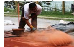
3. Aplicar ankare zoline (capa rodadura) y alisar con llana para fijar el color en dos o tres veces
