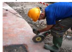
9. Realizar cortes de juntas a los 5/7 días
