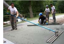
2. Alisar la superficie de hormigón fresco con talocha de magnesio para abrir poro
